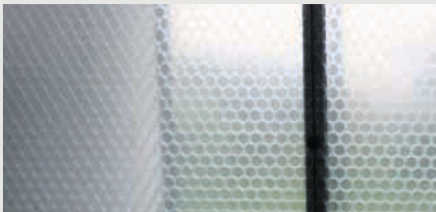
Luftpolster-Isolierfolie (Noppenfolie) 3-schichtige Isolierfolie mit Luftpolstern. (Die Klebelemente werden mit Silikon einmalig an die Sprossen geklebt)
